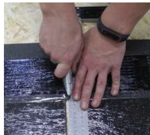
Рис. 77. Деление плитки на лепестки
