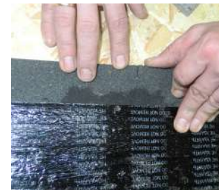
Рис. 76. Насечка для облегчения монтажа
