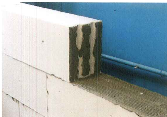
Фото конструкции стены №2
