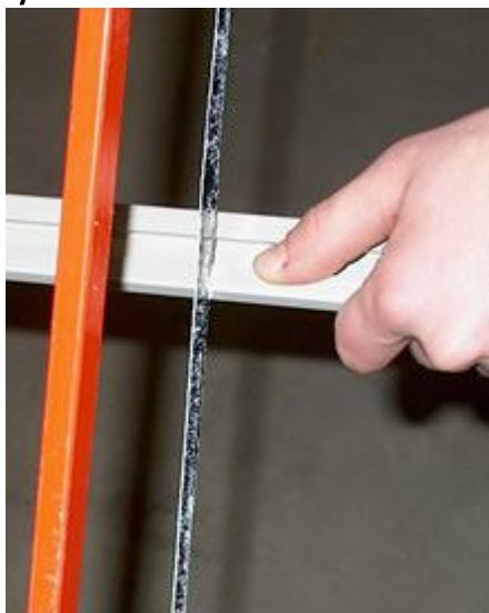
*Используя планки и клипсы квалифицированный мастер сможет выложить стены панелями с производительностью примерно 5 м<sup>2</sup>/час*
