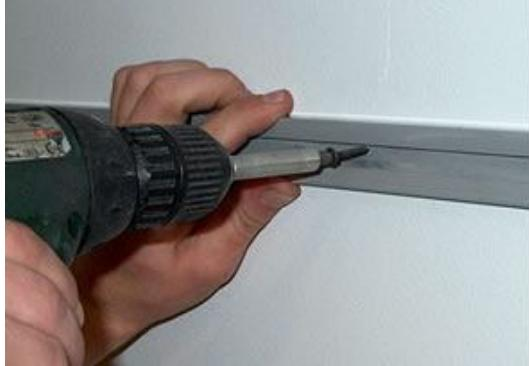
**2. Рейки крепятся параллельно на расстоянии 30-50 см**
