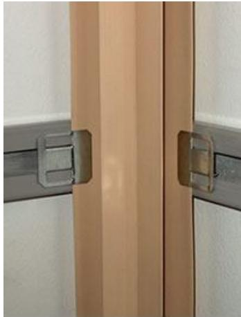
**5. Вставив панель в угловой профиль, прищелкните скобой её язычок к монтажной рейке. Следующую панель вставьте в предыдущую и также прищелкните её**
