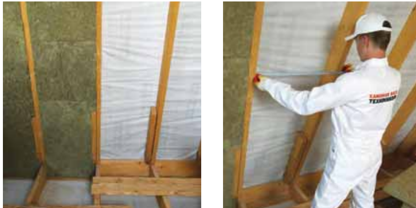
Рис. 4.3. Подготовленная система для дальнейшего монтажа теплоизоляции
