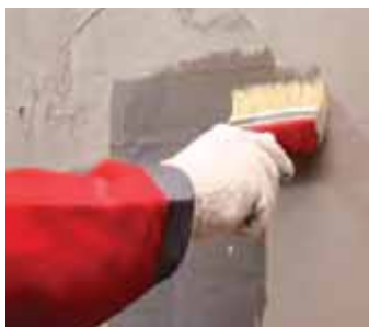
Рис. 7.19. Подготовка основания
