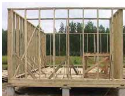
Рис. 7.14. Готовый деревянный каркас
