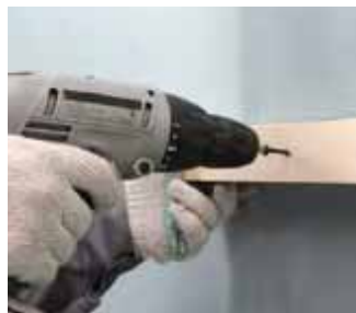
Рис. 7.20. Установка стартового профиля
