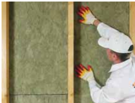
Рис. 7.16. Монтаж теплоизоляционных плит
