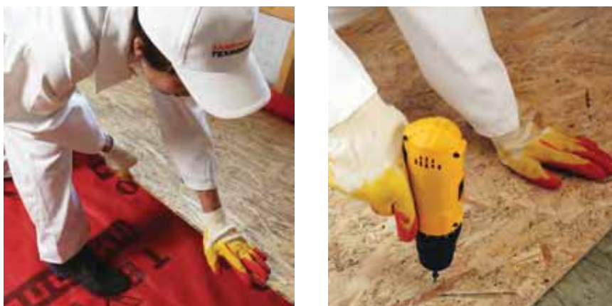
Рис. 5.5. Монтаж листов ОСП чернового пола
