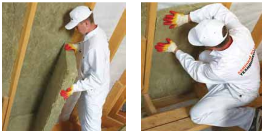
Рис. 4.4. Монтаж теплоизоляции в распор между стропилами
