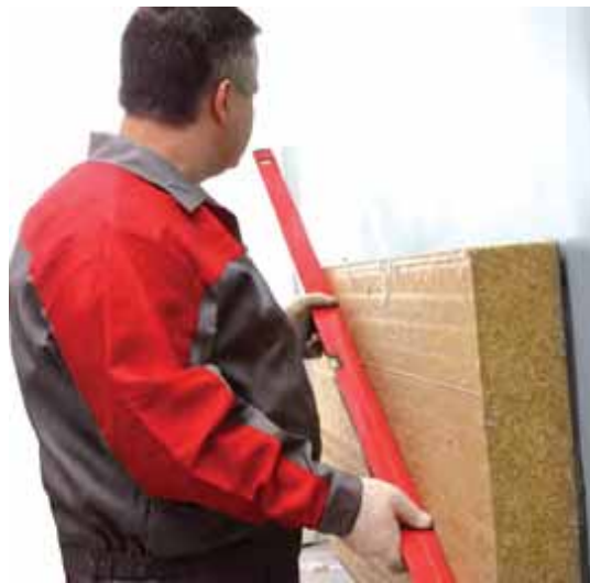
Рис. 7.27. Проверка геометрии
