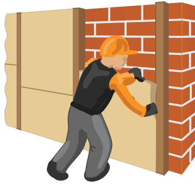
Рис. 7.3. Монтаж теплоизоляционных плит в вертикальный каркас
