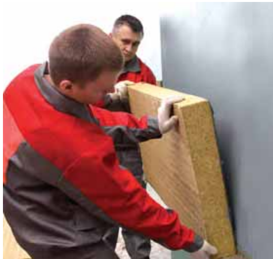
Рис. 7.24. Приклейка теплоизоляции
