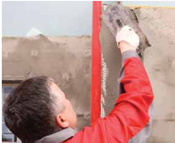
Рис. 7.30. Армирование базового штукатурного слоя стеклосеткой
