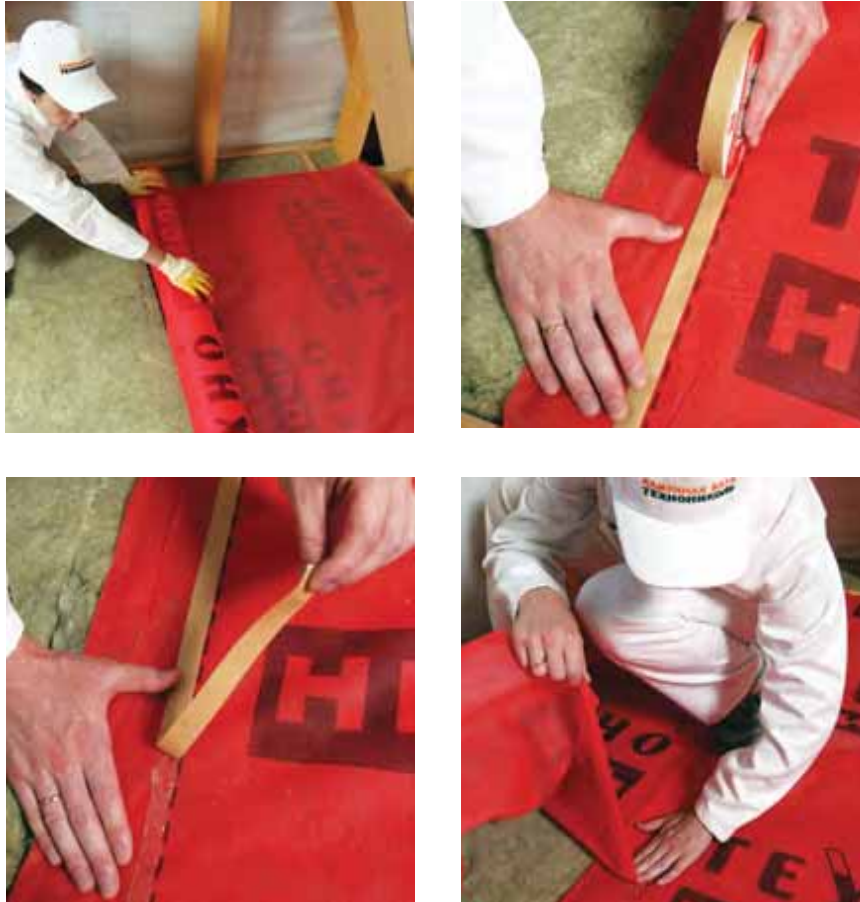
Рис. 5.4. Монтаж пароизоляционной пленки
