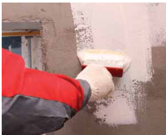
Рис. 7.31. Грунтовка поверхности
