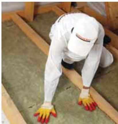
Рис. 4.13. Монтаж теплоизоляции между балками
