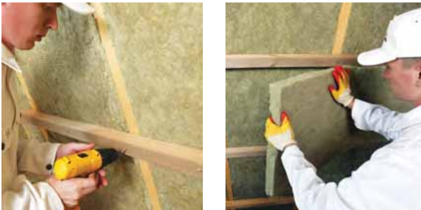
Рис. 4.5. Укладка второго слоя теплоизоляции
