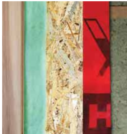
Рис. 5.6. Слои системы пола по лагам
