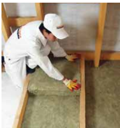
Рис. 5.3. Монтаж теплоизоляции в распор между лагами
