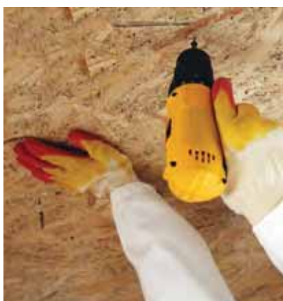
Рис. 4.12. Подшивка потолка листами ОСП
