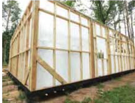
Рис. 7.15. Монтаж пароизоляционной пленки
