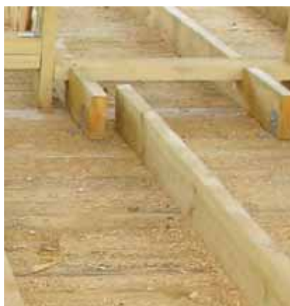
Рис. 5.2. Подшивка лаг снизу
