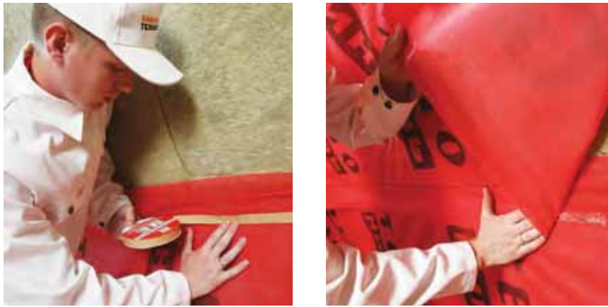
Рис. 4.7. Проклейка стыков пароизоляционной пленки
