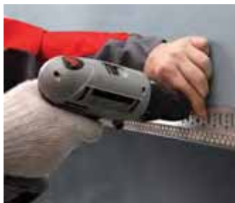
Рис. 7.20. Установка стартового профиля
