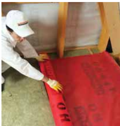
Рис. 4.14. Монтаж ветро-влажностной пленки
