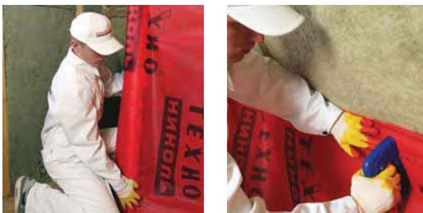
Рис. 4.6. Укладка и фиксация пароизоляционной пленки
