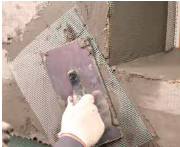
Рис. 7.28. Процесс усиления угла проема элементом из стеклосетки
